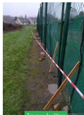
Travaux de clôture
